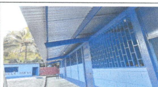
FOTO 4: Fabricación e instalación de balcones de hierro en ventanas modulo 1
