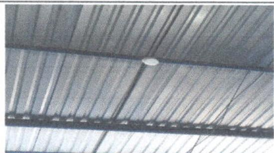
FOTO 1: Sustitución de lámina por lámina troquela aluzinc calibre 26 modulo 1
